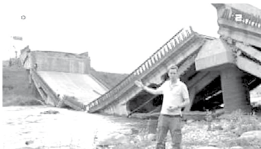
Figuur 3. Brug gebouwd voor gemiddelde belasting.
